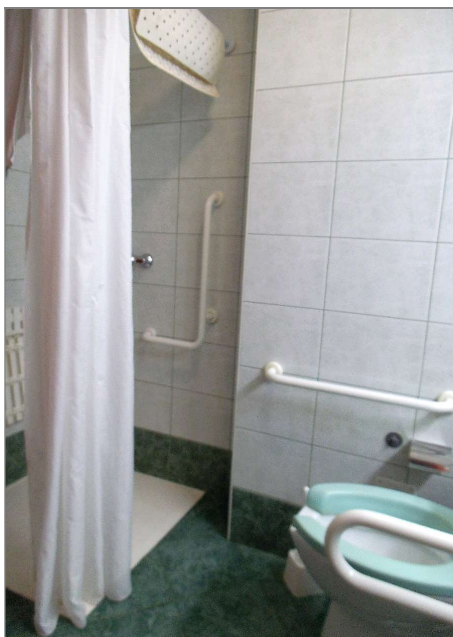
Pohled do zrenovované bezbariérové koupelny
