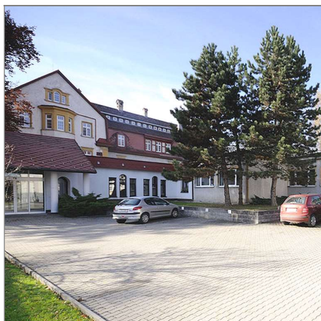
Vstupní část rehabilitačního ústavu
