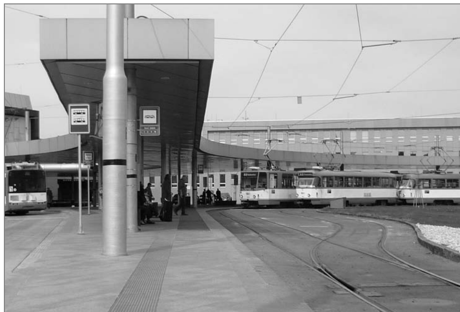
Celkový pohled na tramvajovou, trolejbusovou i autobusovou zastávku MHD Hlavní nádraží
