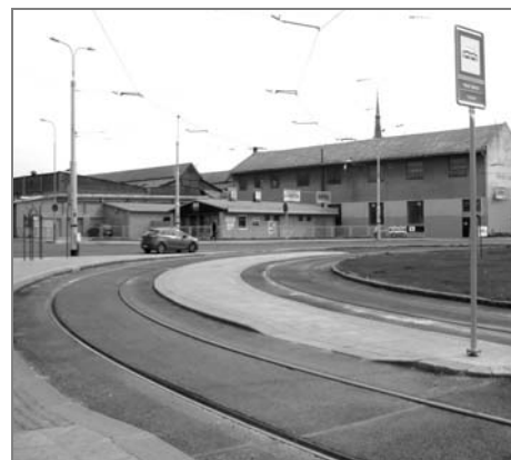
Výstup z tramvají v oblouku
