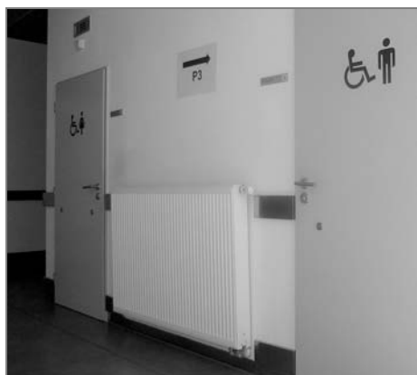
Vstup k bezbariérovým WC, které mají zvlášť kabínu pro ženy i pro muže
