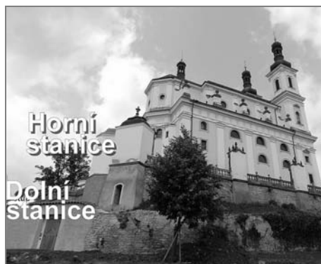
Obr. 4: Bezbariérový vstup do poutního chrámu na Chlumku
