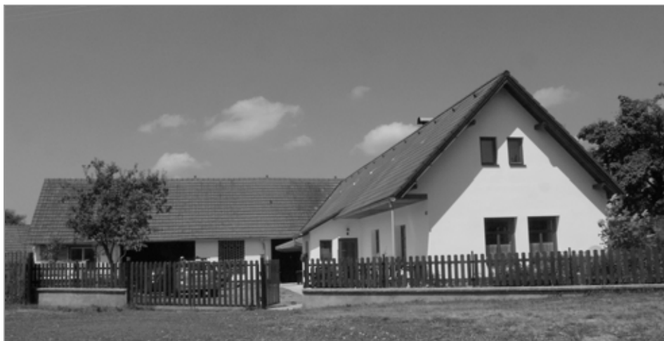
Bezbariérově zrekonstruovaná venkovská chalupa v Bratřicích.
