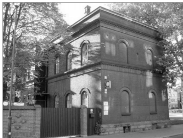
Budova poradny Charity Ostrava na Jeremenkově ul. 8 v Ostravě-Vítkovicích
