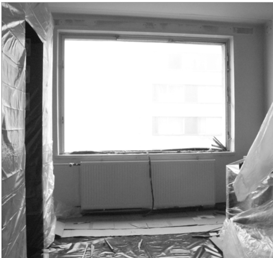
Díra zející po vybourání starého třídílného okna.
