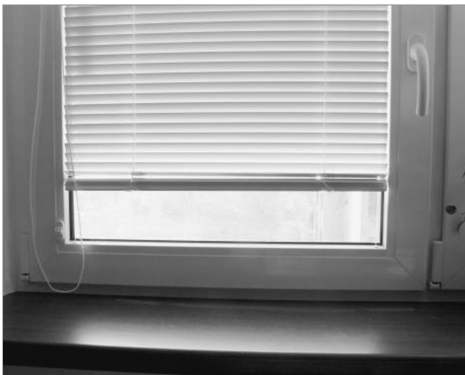
Čtyři polohy kliky: 1. zamčeno, 2. otevřeno jako křídlo, 3. spárové větrání, 4. otevřeno jako ventilačka.
