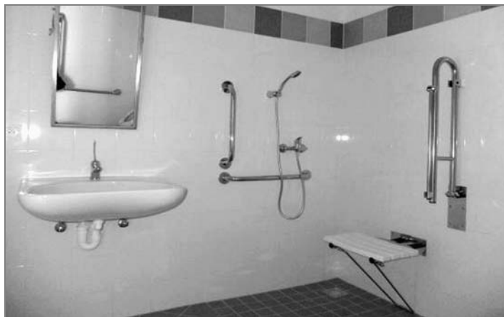
Koupelna je vybavena umyvadlem, sklopnou sedačkou s madly a naklopeným zrcadlem
