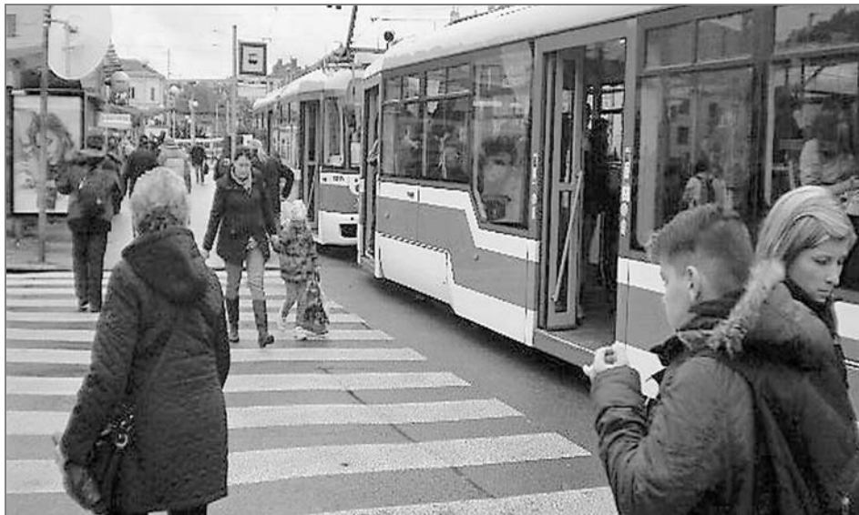
Zastávka tramvajů na Mendlově náměstí po nedávné rekonstrukci, kde nízkopodlažní část tramvaje stojí mimo nástupiště na vozovce
