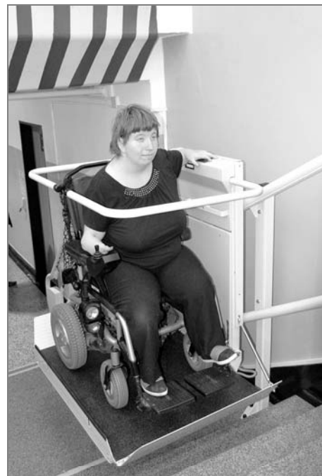
Nové plošiny na rozdíl od předchozích umožňují přepravu i na elektrických vozíčkách
