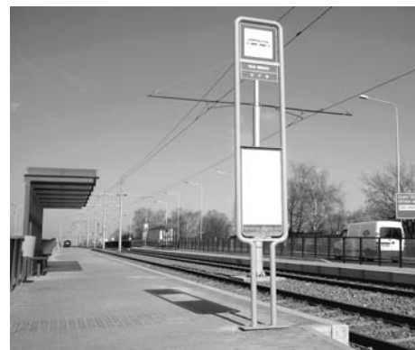
Pohled po výjezdu rampou z podchodu pod komunikací Plzeňská
