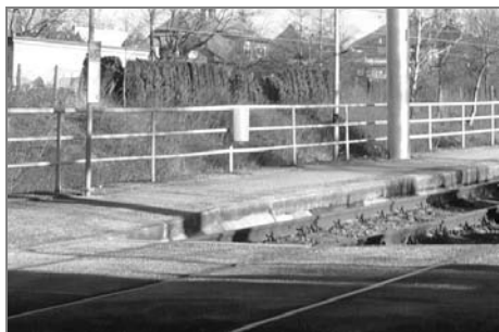
Rekonstruovaná tramvajová zastávka
