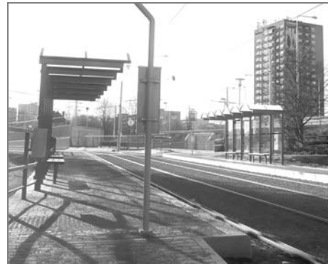
Nově vybudovaná tramvajová zastávka
