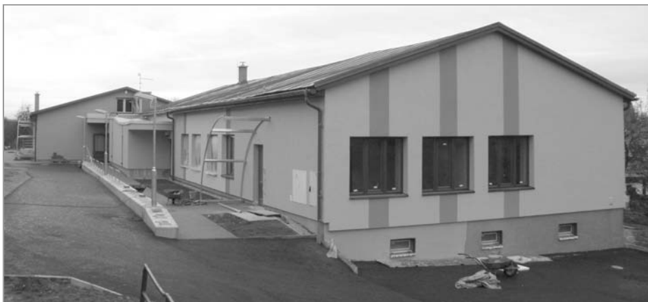
Moderní komplex odlehčovací služeb pro dospělé s mentálním a kombinovaným postižením v Lukavci na Vysočině (foto těsně před dokončením).
