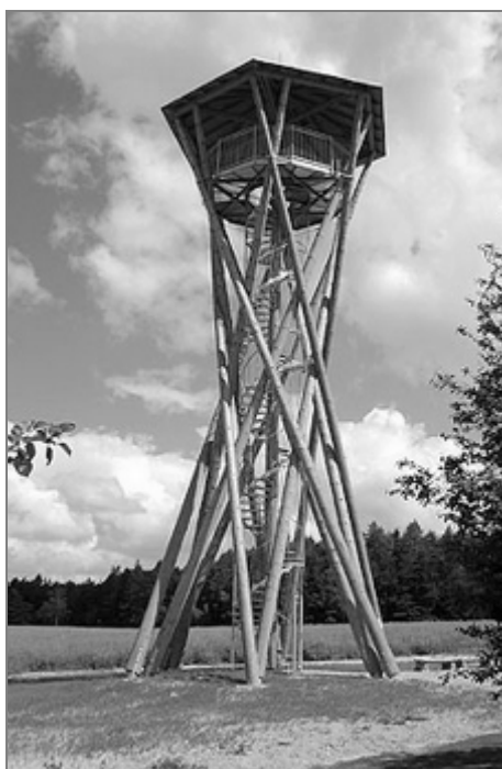
Zajímavá konstrukce rozhledny Borůvka
