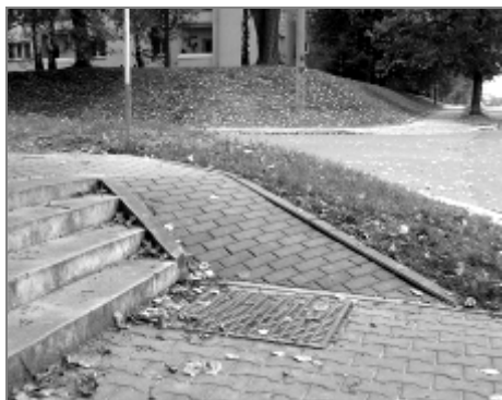
Pohled zespodu: schody a vedle „bezbariérový“ přístup
