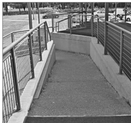
Horní část šikmé rampy k recepci je také příliš prudká
