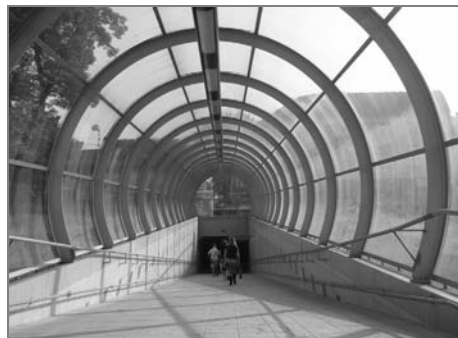
Nájezdová rampa ze strany Cingrova ulice
