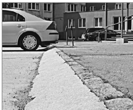
Nájezd na chodník z plochy parkoviště je příliš strmý
