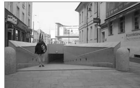
Nová nájezdová rampa do podchodu ze Stodolní ulice
