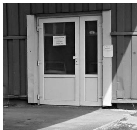
Vchod přes zadní trakt hotelu je pro vozíčkáře bezproblémový
