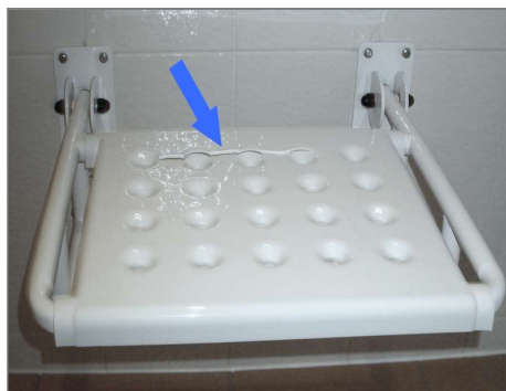
Celkový pohled na sedátko s prasklinou
