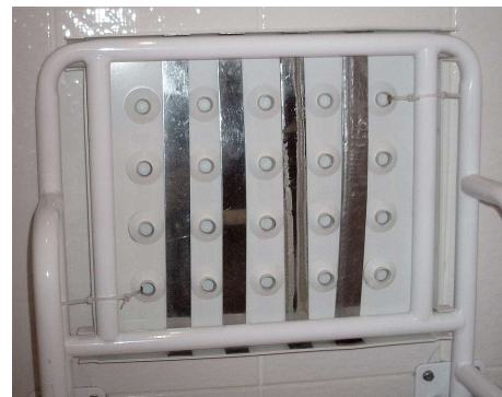
Pohled zdola na nové sedátko vylepšené proti prasknutí čtyřmi příčnými páskami antikorového (nerez) plechu
